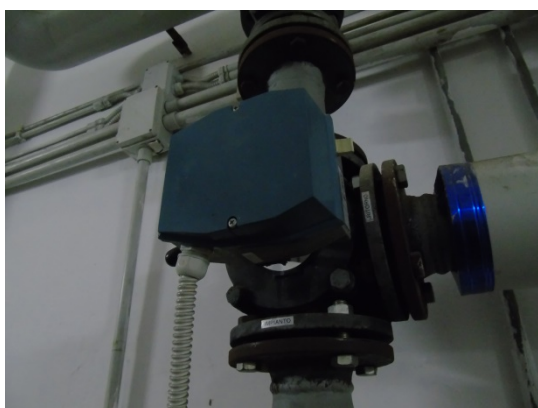
Figura 4.6 - Particolare della valvola miscelatrice
