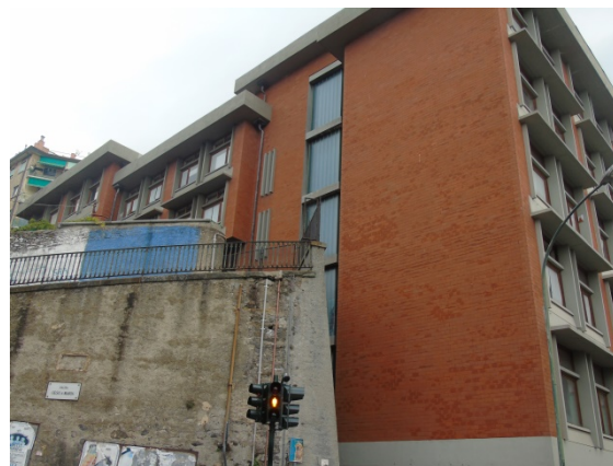
Figura 4.1 - Particolare della porzione di involucro
