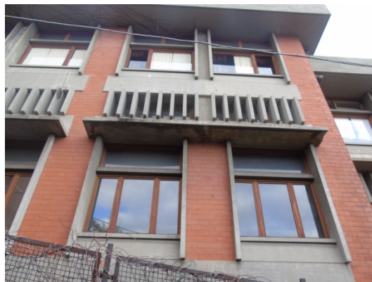
Figura 1.1 - Vista della facciata esposta a ovest
