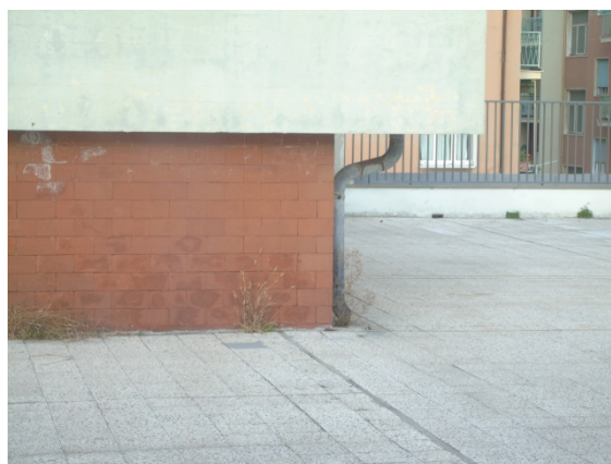
Figura 8.1 - Particolare copertura piana su cui intervenire.
