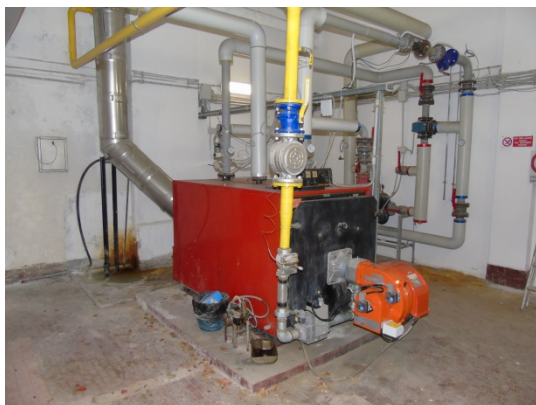
Figura 4.10 - Generatore di calore
